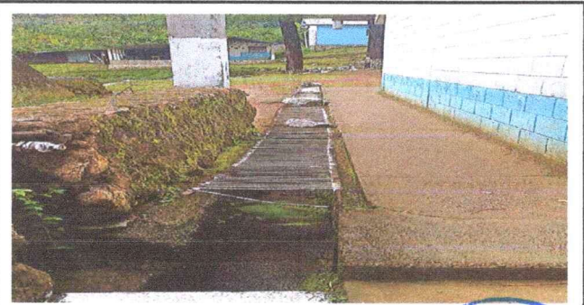
Foto 5: Reparación de cuneta de concreto y colocacion parrillas
